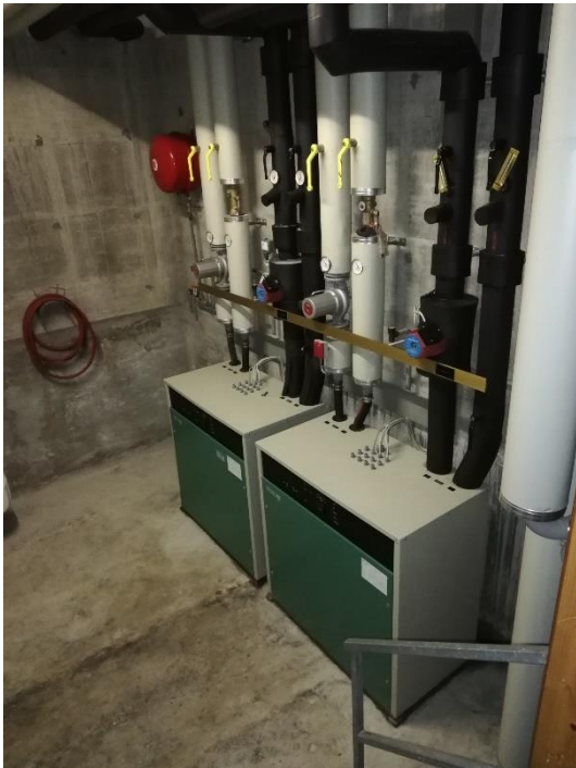
Bestehende Wärmepumpe
