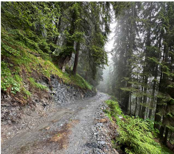
Noterschliessung Varduz in Duvin: Auf einer Länge von 1500 Metern wurde eine Noterschliessung über einen historischen Erschliessungsweg (vor 1934) erstellt.
