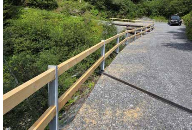
SIE Ranasca Val Grep Stiafen in Pigniu: Frisch sanierte Walderschliessung mit Absturzsicherung.
