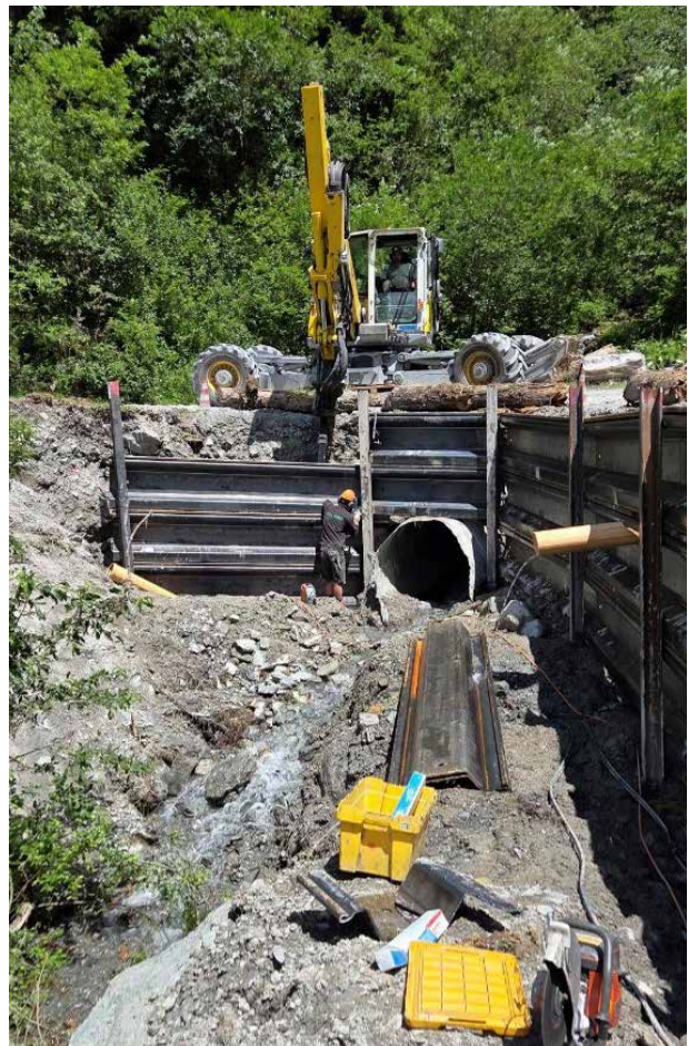
SIE Ranasca Val Grep Stiafen in Pigniu: Erstellung der Ankerpfahlwand.
