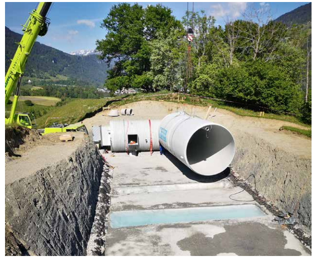
Das neue Reservoir in Castrisch.
