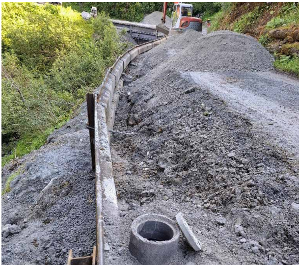
SIE Ranasca Val Grep Stiafen in Pigniu: Erstellte Hangsicherung vor der Hinterfüllung.
