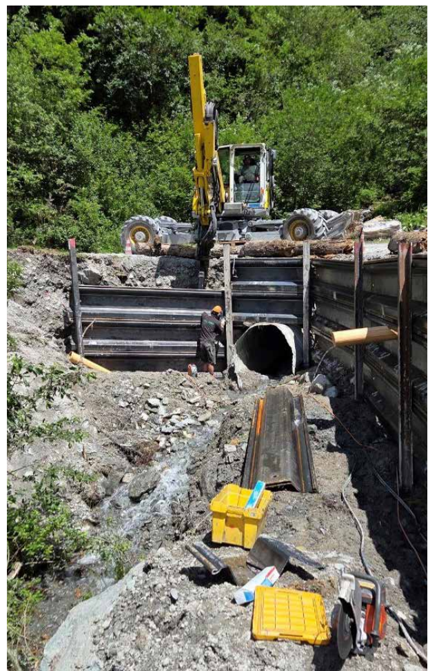
SIE Ranasca Val Grep Stiafen a Pigniu: Construcziun da pals d'ancra.
