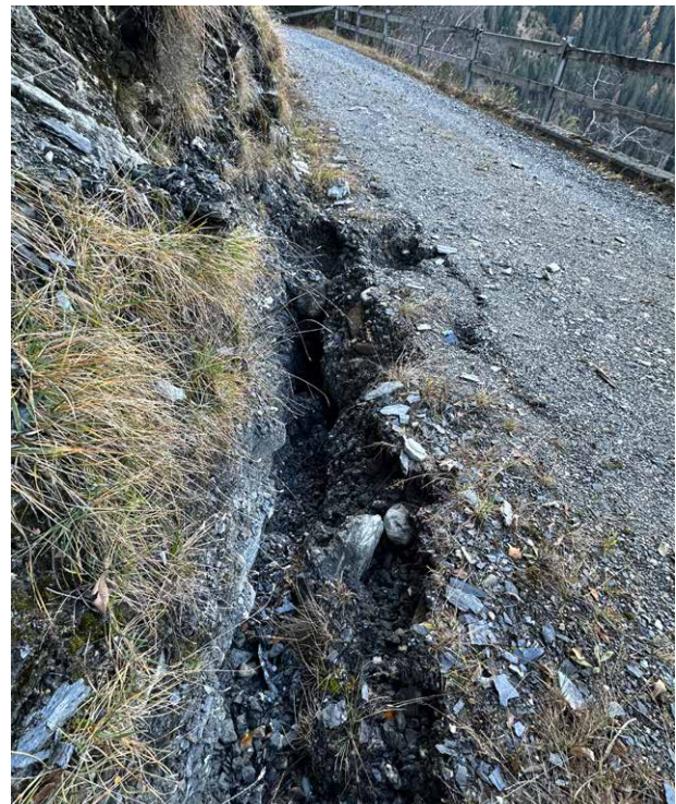
Avertura Varduz a Duvin, Val da Sum Punt. Scarps bein vesibels dil corpus dalla via naven dil grep.
