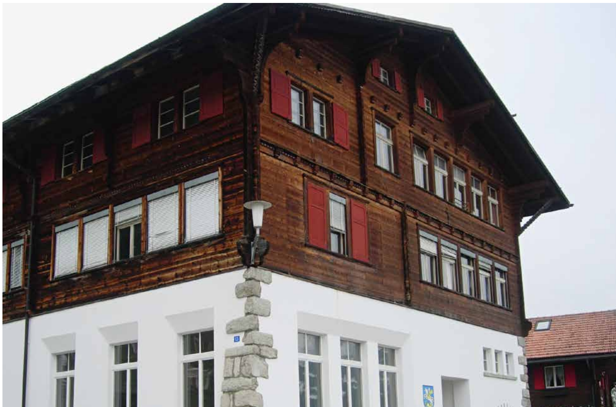
Das ehemalige Gemeindehaus in Ruschein.
