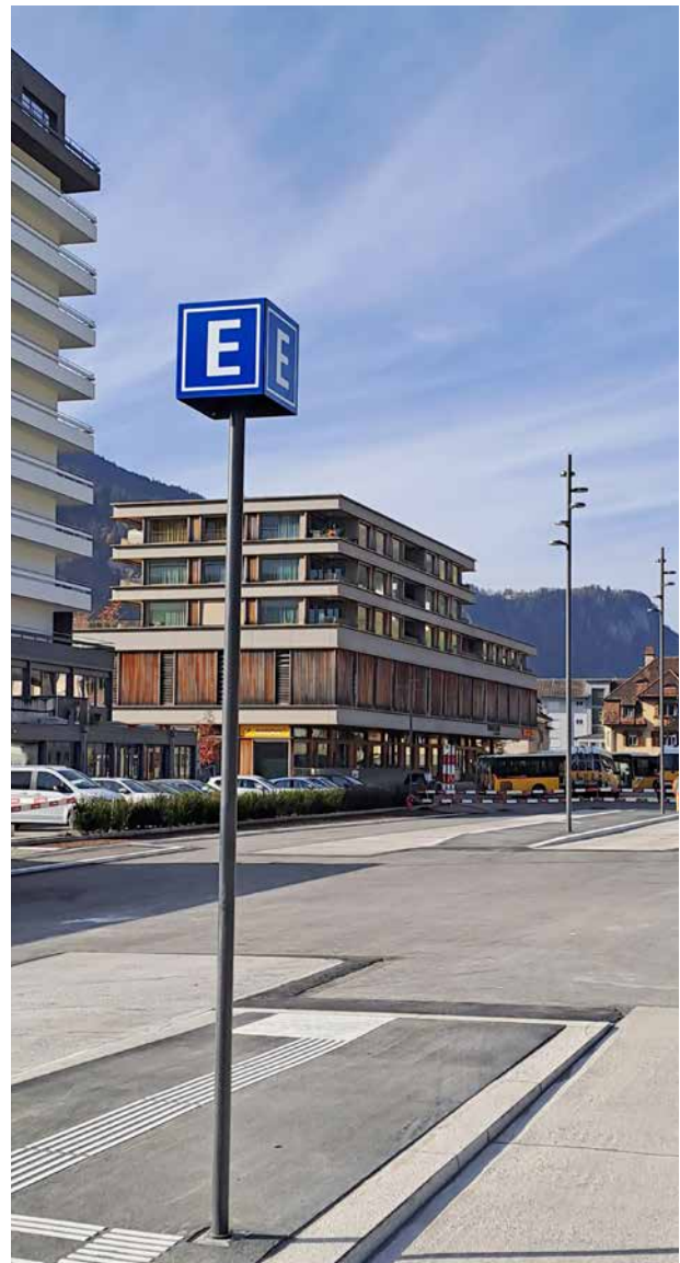
Abschluss der Arbeiten am neuen Postautoterminal am Bahnhof Ilanz.
