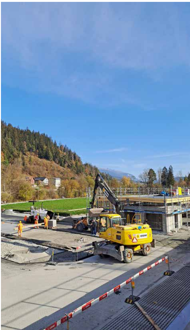
23 Die Bauarbeiten an der P+R Anlage im Gebiet Pendas in Illanz.
