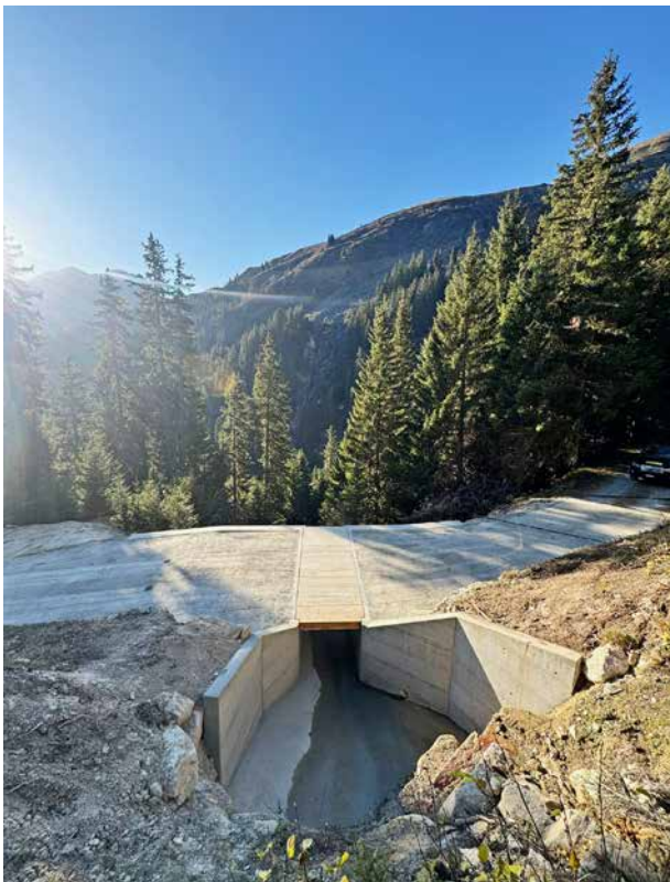
Neu erstellter Wasserkanal mit Einlaufsicherung bei der Alpstrasse Cavel.
