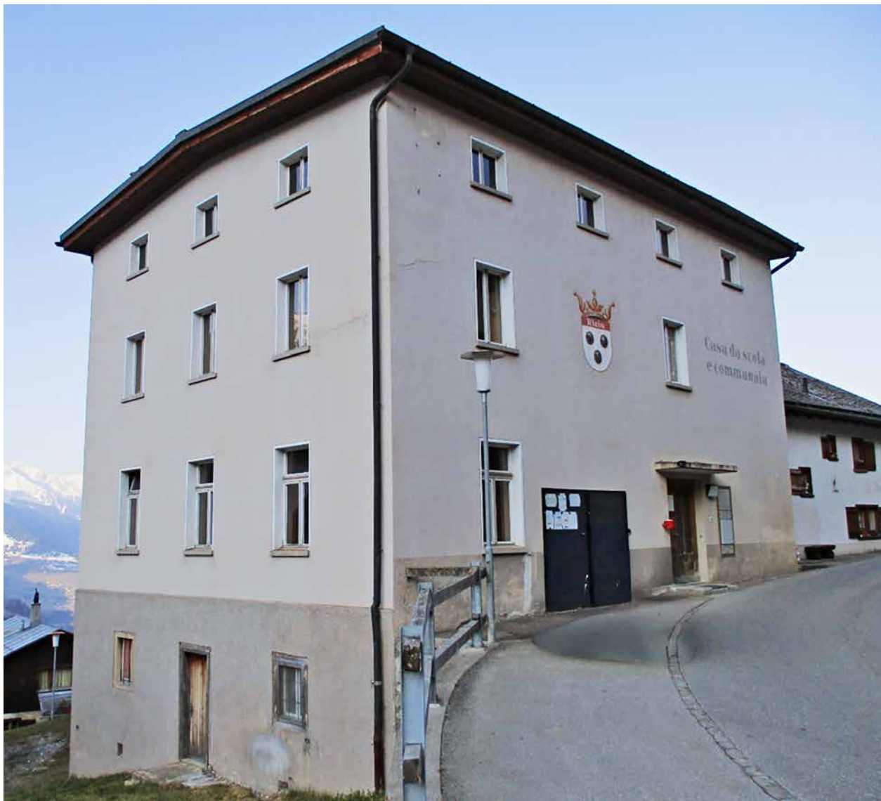
L'antieriura casa communal a Riein.
