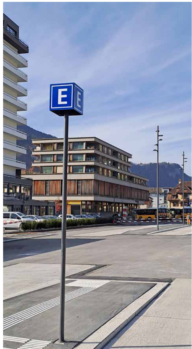
Las lavurs per il niev terminal d'autos da posta alla staziun da Glion van a fin.
