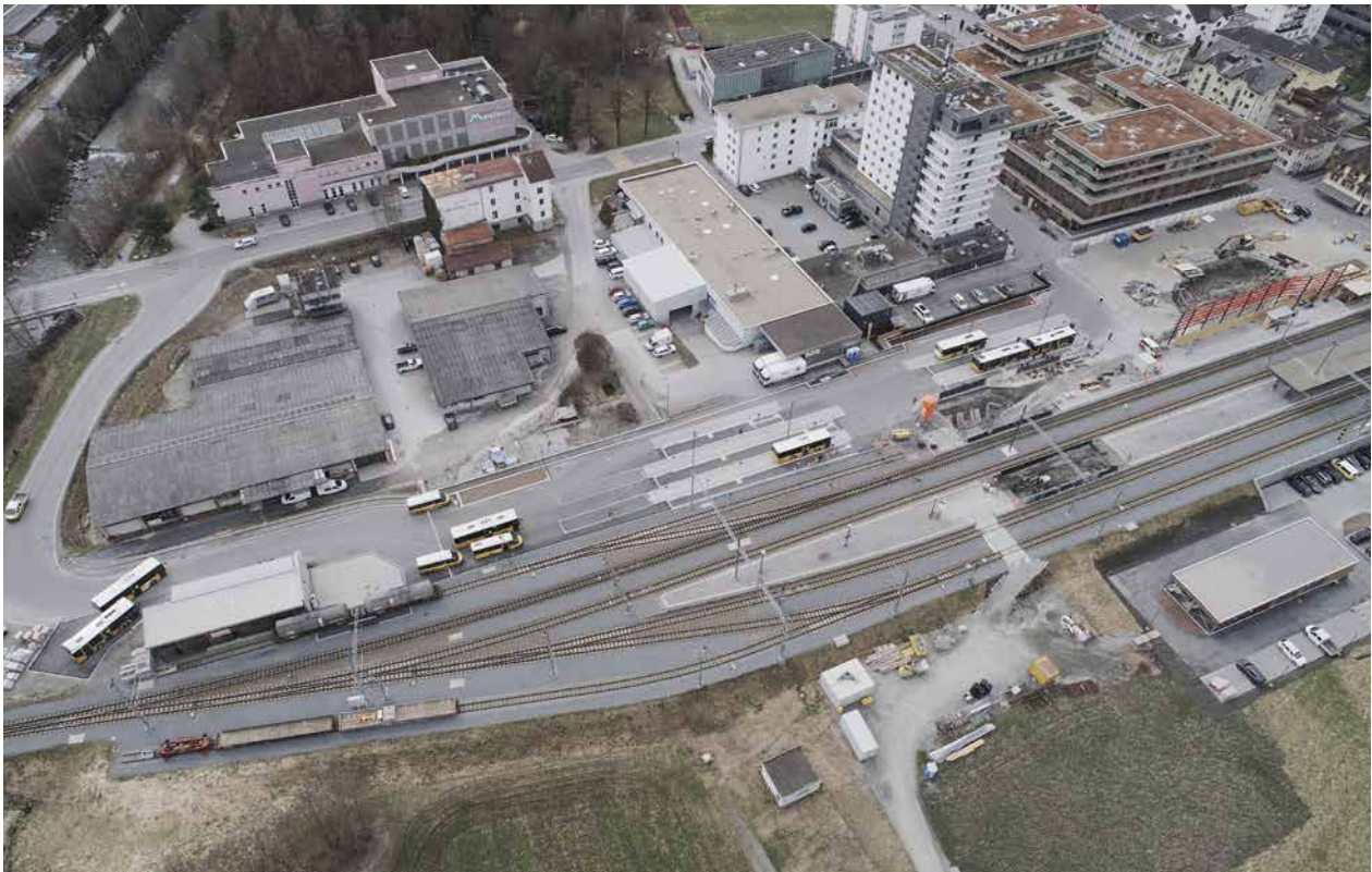
La renovaziun dgl areal dalla staziun da Glion progredescha.
