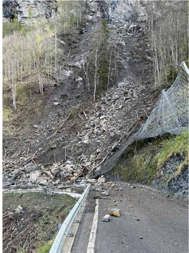
La via cantunala a Riein: Il cundrez per proteger da curdadas da crappa ei staus claramain sutdimensionaus per quei eveniment.
