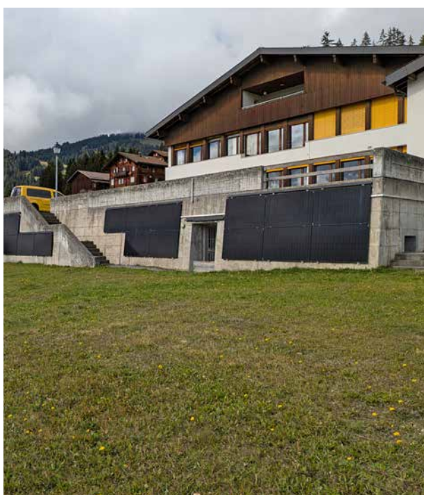
27 Igl implont solar vid il mir da sustegn dalla Casa Sentupada a Siat.
