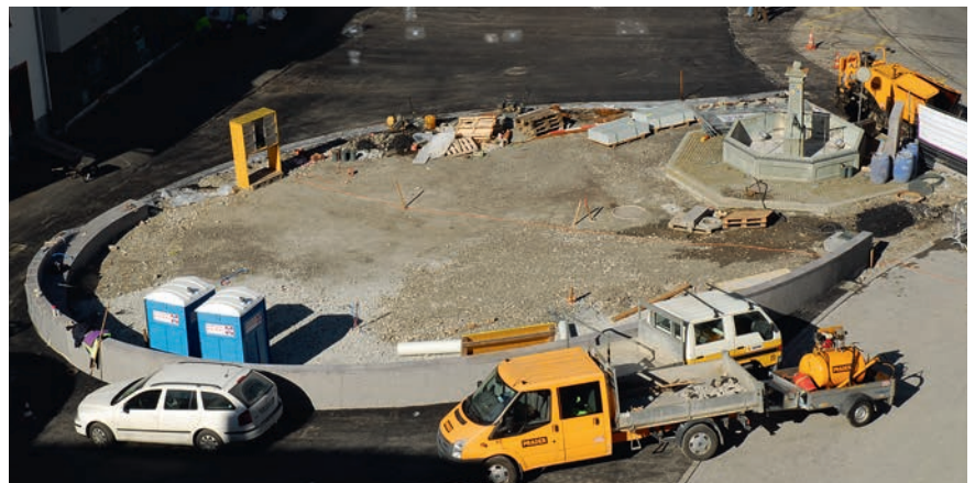
Der Platz nimmt Gestalt an: Mitte Oktober waren die Arbeiter mit dem Belageinbau und der Pflasterung beschäftigt. Deutlich sichtbar wird die Bedeutung des Stadtbrunnens. Foto abc
